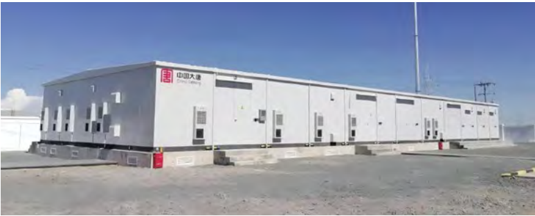
▲ 2024 年 8 月 15 日，中国大唐在青首个储能项目成功并网——大唐兴海大基地 50 万千瓦光伏配套储能项目顺利实现并网，对于构建安全高效、绿色低碳、柔性灵活、智慧融合的新型电力系统和能源保供具有重要意义。
