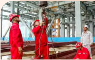
▲ 烈日下的施工人员不间断地吊装着锅炉钢架
