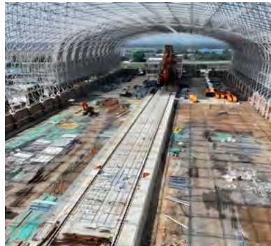
▲ 陡电 2×660 兆瓦燃煤热电项目
