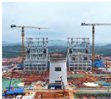
▼ 株洲 2×100 万千瓦扩能升级改造项目
